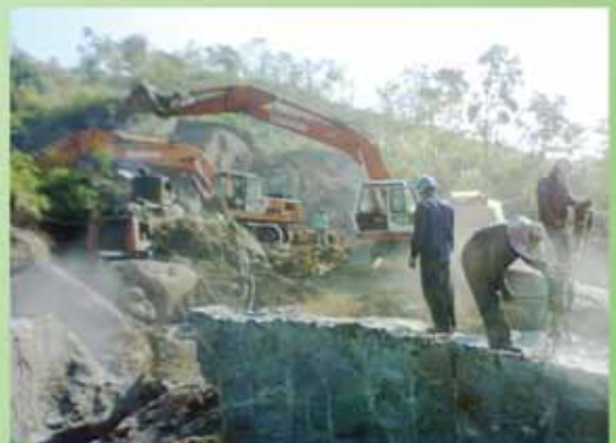
Hình ảnh công trường khai thác đá
